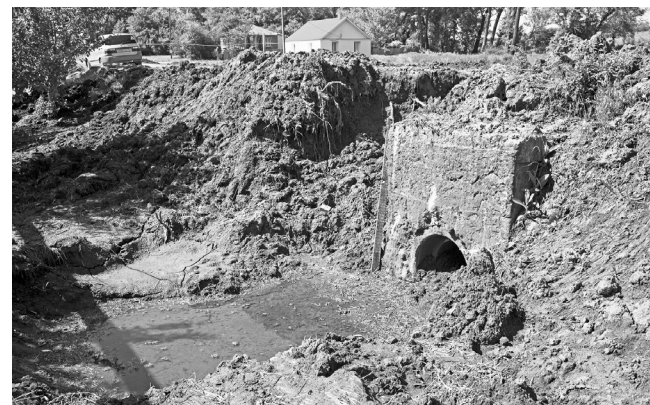
Труба по другую сторону от дома тоже не могла справиться с потоками воды
