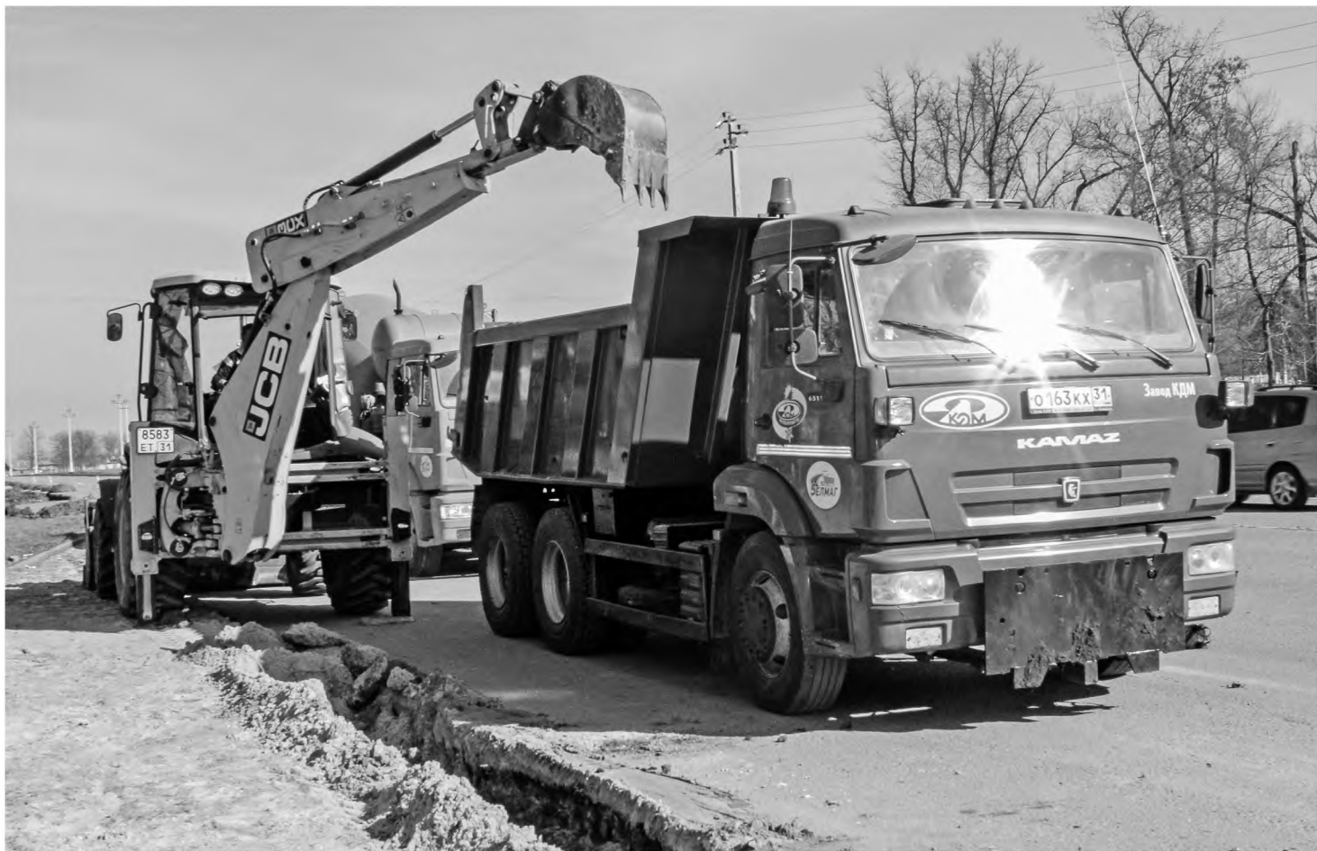
Подготовка мест для укладки новых бордюров
